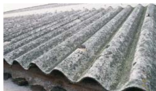
Toiture en amiante-ciment
