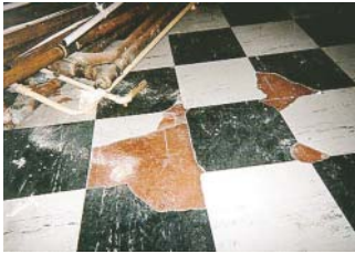
Dalles de sol
