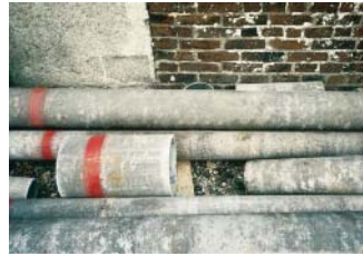
Canalisation en amiante-ciment
